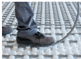
Sencilla y cómoda colocación del tubo.
