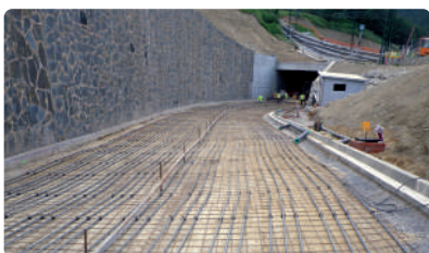
Entrada a túnel en el Pirineo.
