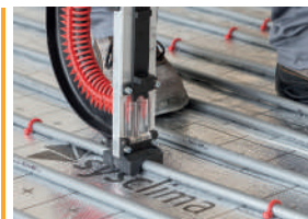
Cómoda colocación del tubo con grapa 3D.
