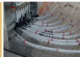
Obra con placa ALU-PG-TA 25-2 y tubo multicapa Sysclima.
